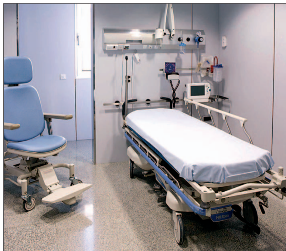
Cada uno de los boxes dispone de oxígeno, vacío, aire comprimido, llamada de emergencia, control permanente por circuito cerrado de televisión y aseo para el paciente.
